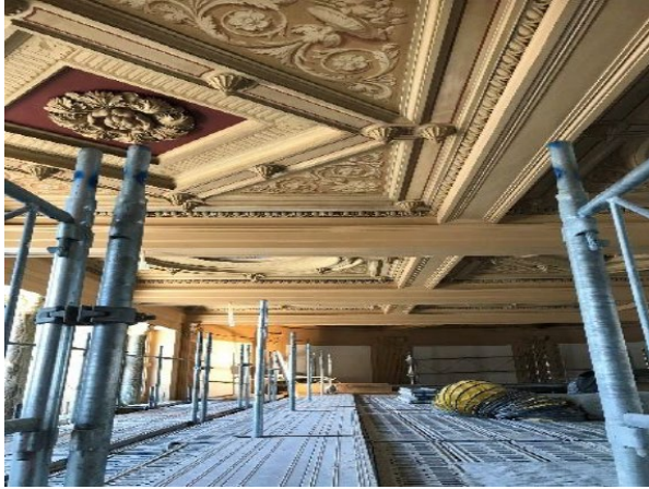
Finalisation peinture plafond Grande Salle
