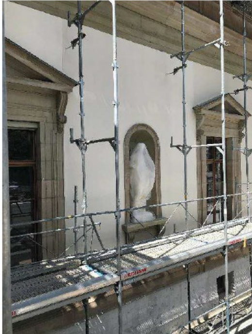
Livraison et mise en place des statues
