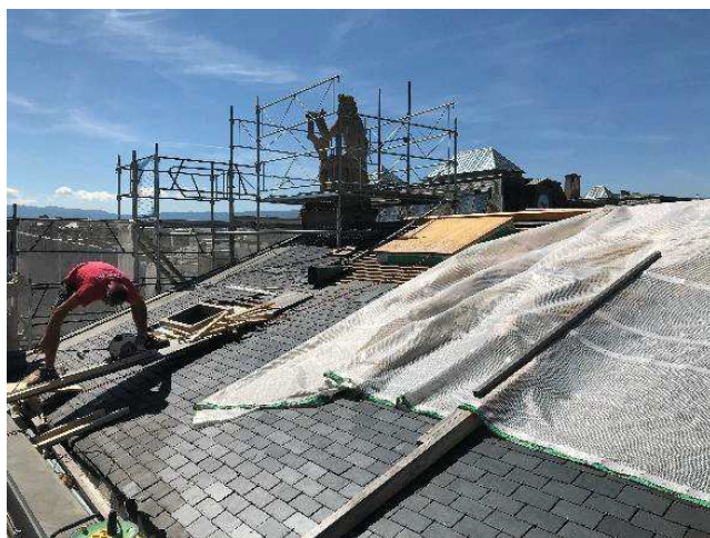
Travaux charpente et pose du revêtement
