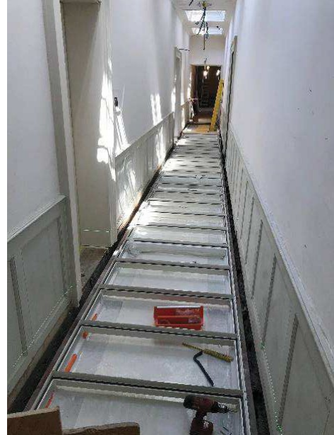
Montage plancher vitré
