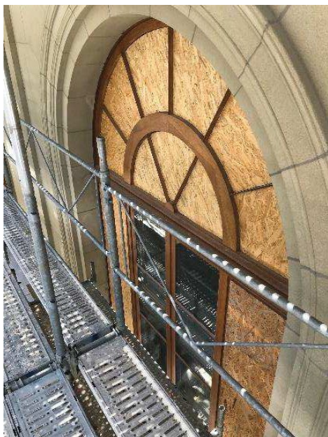
Ouverture façade en attente pose verre
