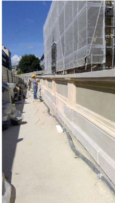
Rapiècement du muret d'enceinte
