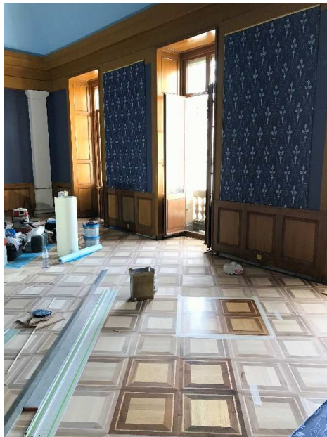
Salle Musique de chambre : test vernis s/parquet
