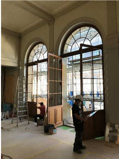
Remise en place et vitrages des portes du Hall
