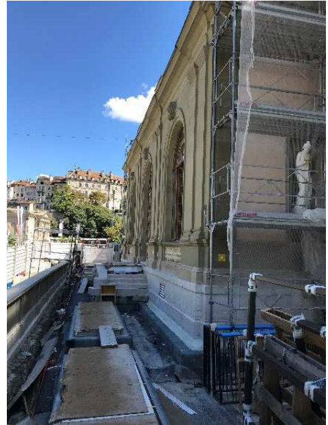
Démontage échafaudages façades
