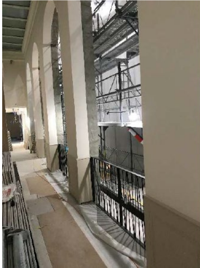
Pose barrières couloirs
