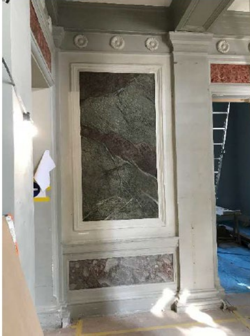
Restauration des faux marbres du Hall
