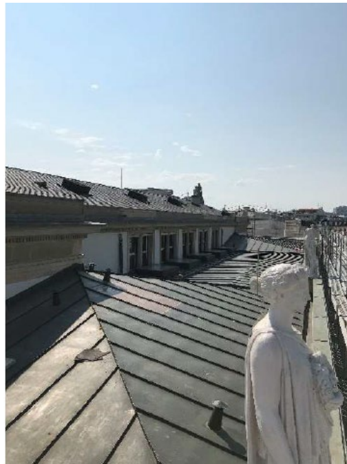
Démontage échafaudages toiture
