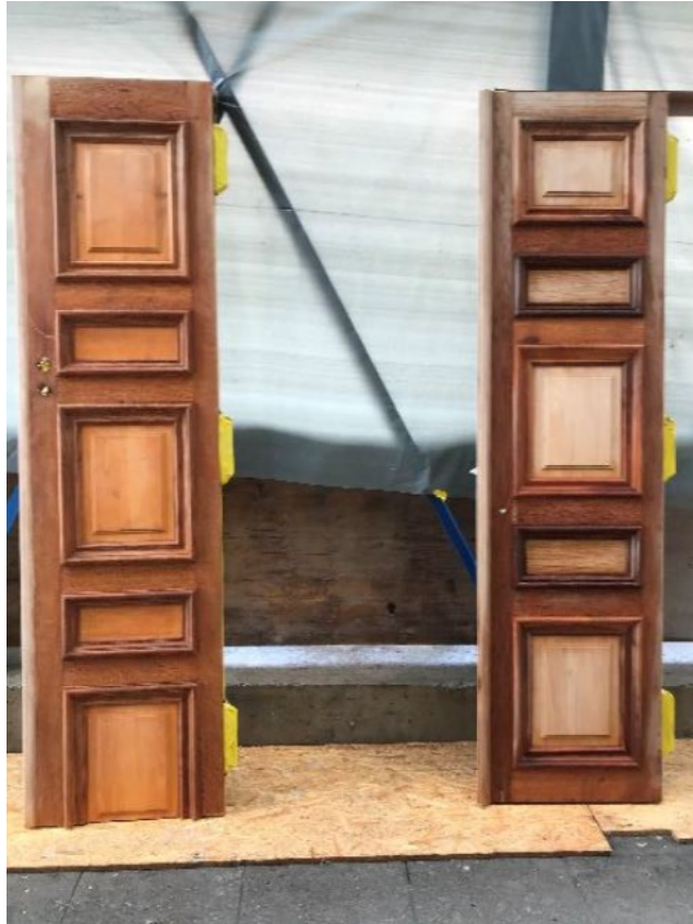
Décapage portes historiques
