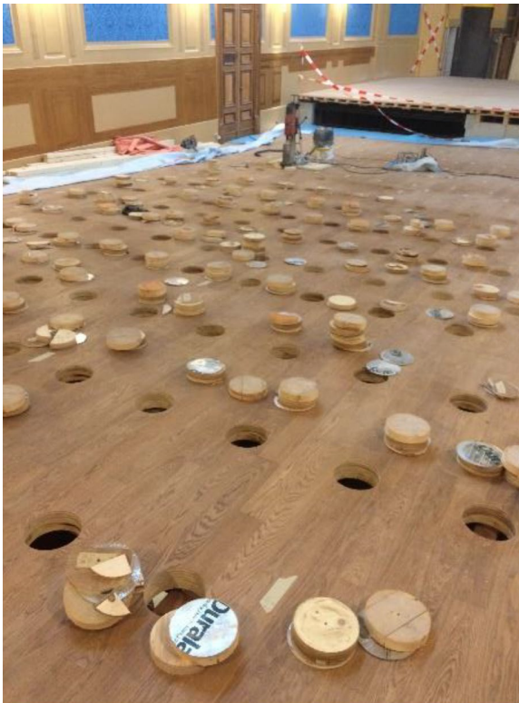
Percement grande salle en cours
