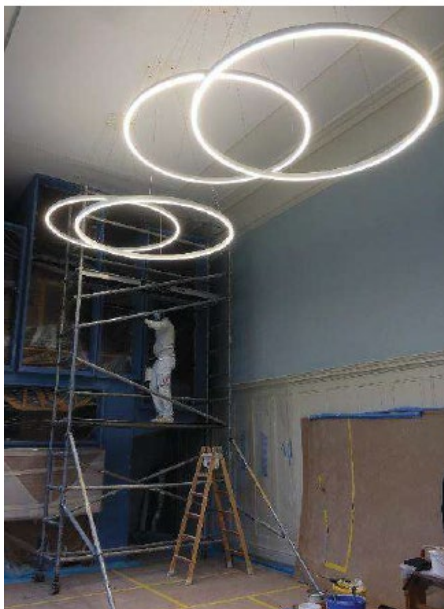
Pose luminaire salle d'orgue
