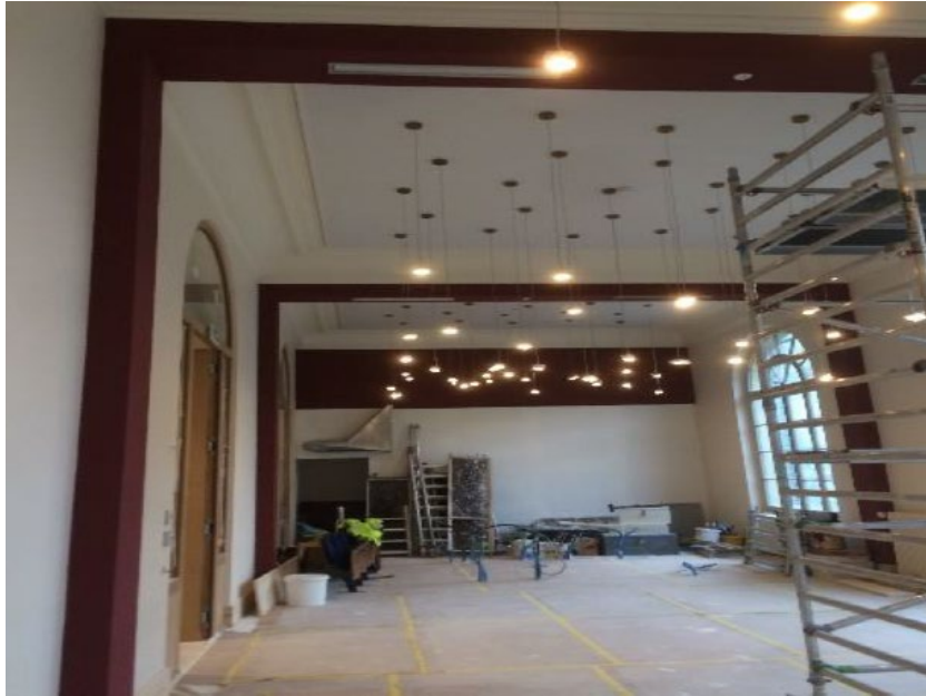
Pose luminaires cafétéria
