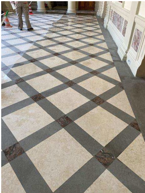
Traitement final pierre hall d'entrée
