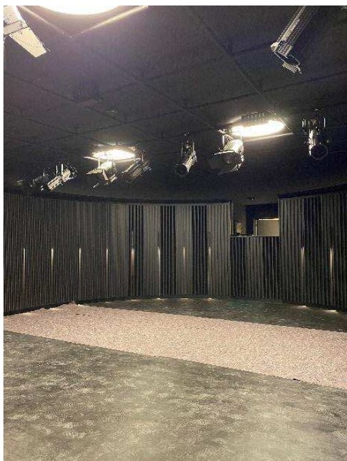
Installation projecteurs Studio Théâtre
