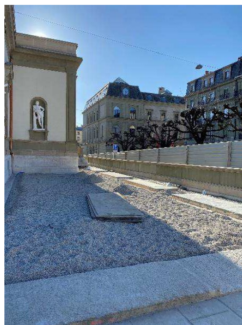
Réfection trottoir en cours
